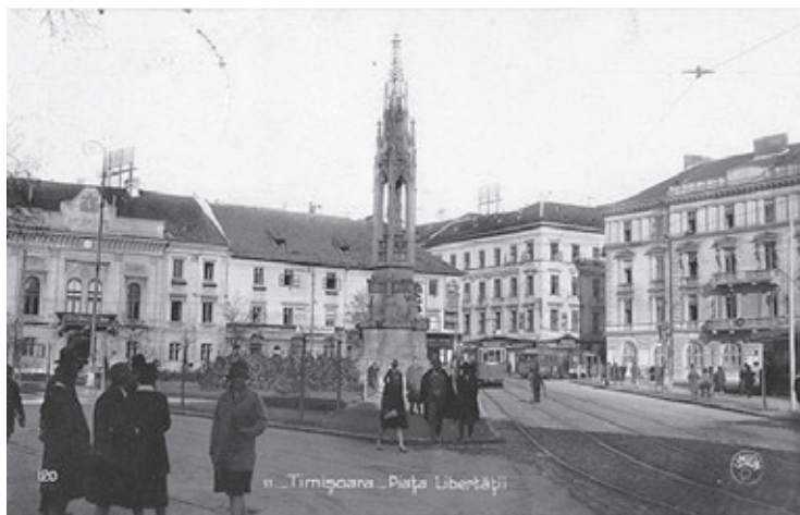
1.a. Monumentul Austriac Rukavina, Timișoara
